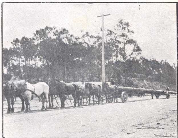
Fig. 53 — Estaca de E. globulus para a bahia de S. Francisco, com 150 pés de comprimento, cortada na plantação de Adolpho Sutro, com 20 annos.
